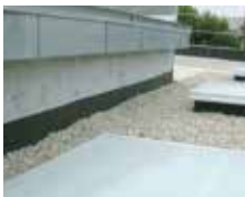
Étanchéité des raccords avec les parements verticaux avec Mopren Top .
