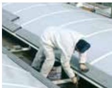
Chéneaux étanchés avec Mopren Top .
